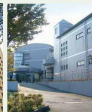
養護老人ホーム メゾンヴェルト (空調・衛生設備改修工事)
