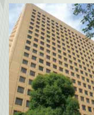
興和川崎西口ビル (衛生器具更新工事)
