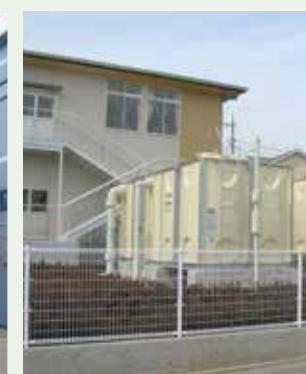
茅ヶ崎北陵高校 (給排水衛生設備新築工事)
